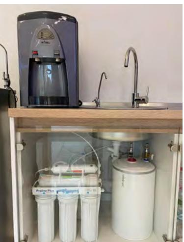
Idealan za tvrtke koje imaju čajnu kuhinju. Filter se ugrađuje u donji kuh.elemenat, a dispencer na radnu površinu, moguće do 7m od filtera.
