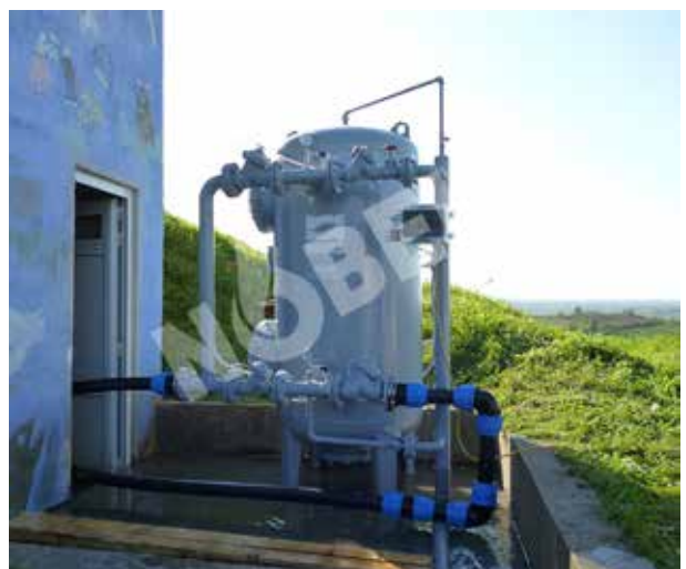
UNDP- Seoski vodovod Gornja Skakava Brčko, Višeslojni pješčani filter
