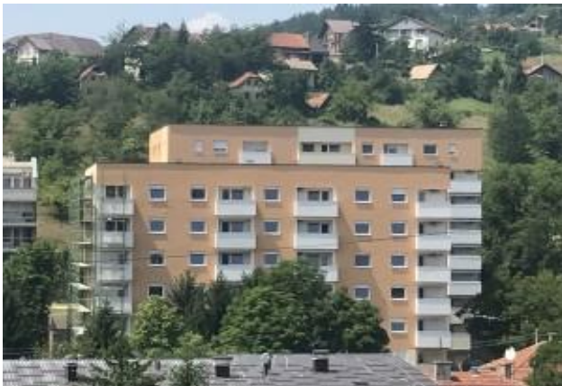
Stambeni objekt Vogošća
