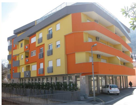
Stambeno poslovni objekt Mostar
